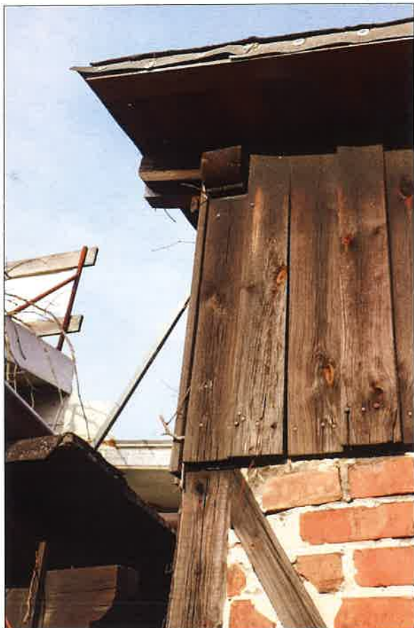
Detal szczytu naroża zachodniego z widocznym opierzeniem (deskowaniem), płatwią i krokwią. (fot. Jakub Andrzejewski, 2020 r.)
