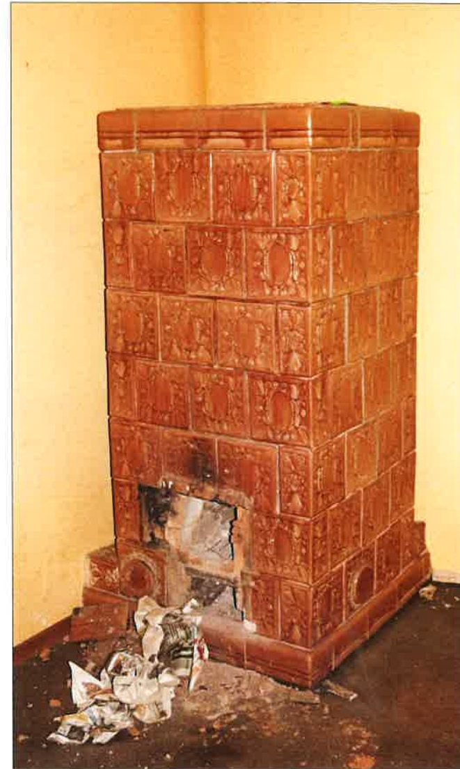
Najprawdopodobniej oryginalny piec kaflowy w pomieszczeniu we wschodnim narożu budynku. Piec został uszkodzony przez bezdomnych włamujących się do budynku. (fot. Jakub Andrzejewski, 2020 r. )
