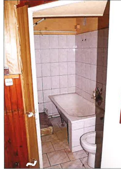
Wtórnie zaaranżowane pomieszczenie łazienki w środkowej części budynku. (fot. Jakub Andrzejewski, 2020 r.)
