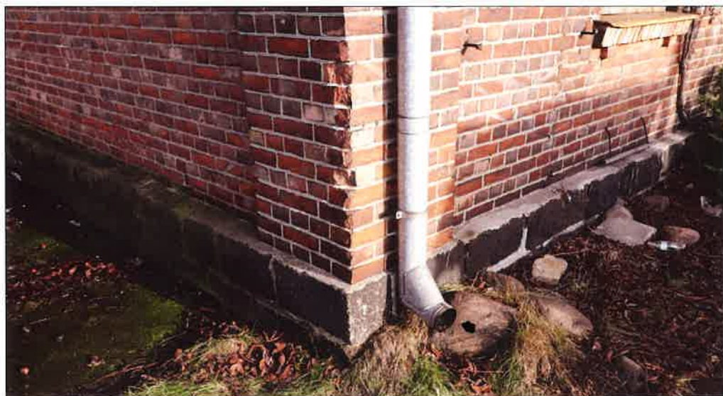
Naroże zachodnie i widoczna ściana fundamentowa wykonana z granitowych ciosów kamiennych na zaprawie wapiennej. (fot. Jakub Andrzejewski, 2020 r.)
