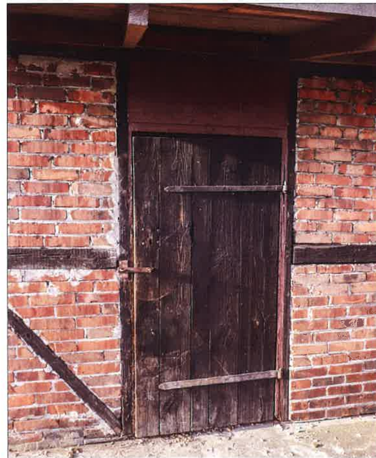
Oryginalne drewniane drzwi deskowo-listwowe z zastrzałem wejściowe do jednego z pomieszczeń w elewacji południowo-wschodniej. (fot. Jakub Andrzejewski, 2020 r.)
