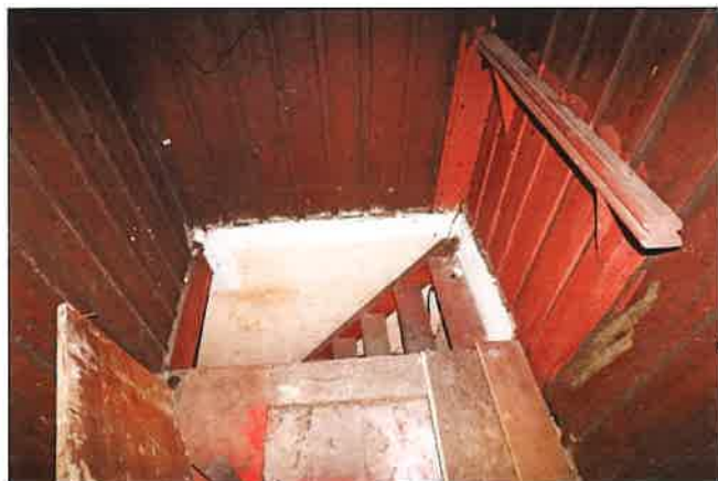
Wyjście z drewnianymi schodami prowadzące do korytarza głównego w parterze budynku. (fot. Jakub Andrzejewski, 2020 r. )
