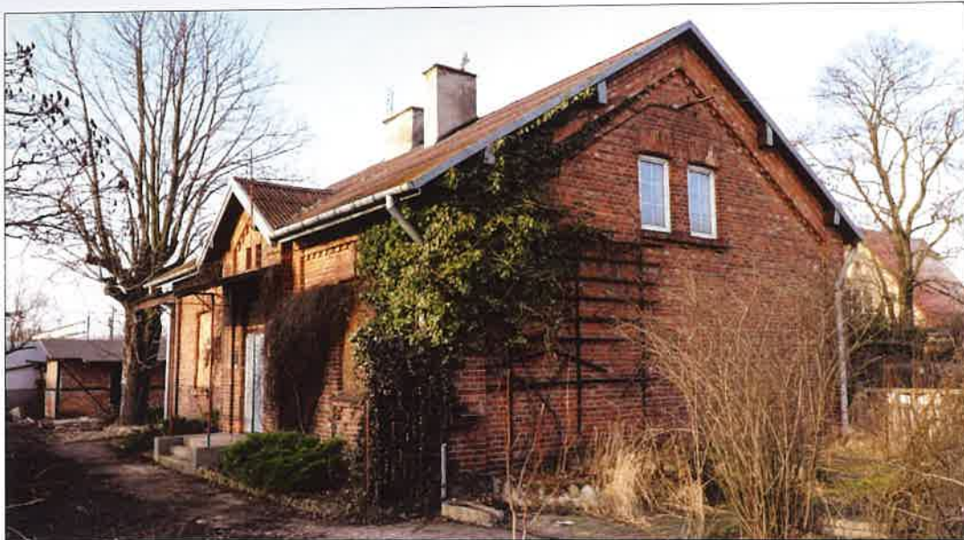
Naroże południowe oraz elewacje południowo-zachodnia (frontowa) i południowo-wschodnia. W głębi po lewej stronie widoczny budynek gospodarczy. (fot. Jakub Andrzejewski, 2020 r.)
