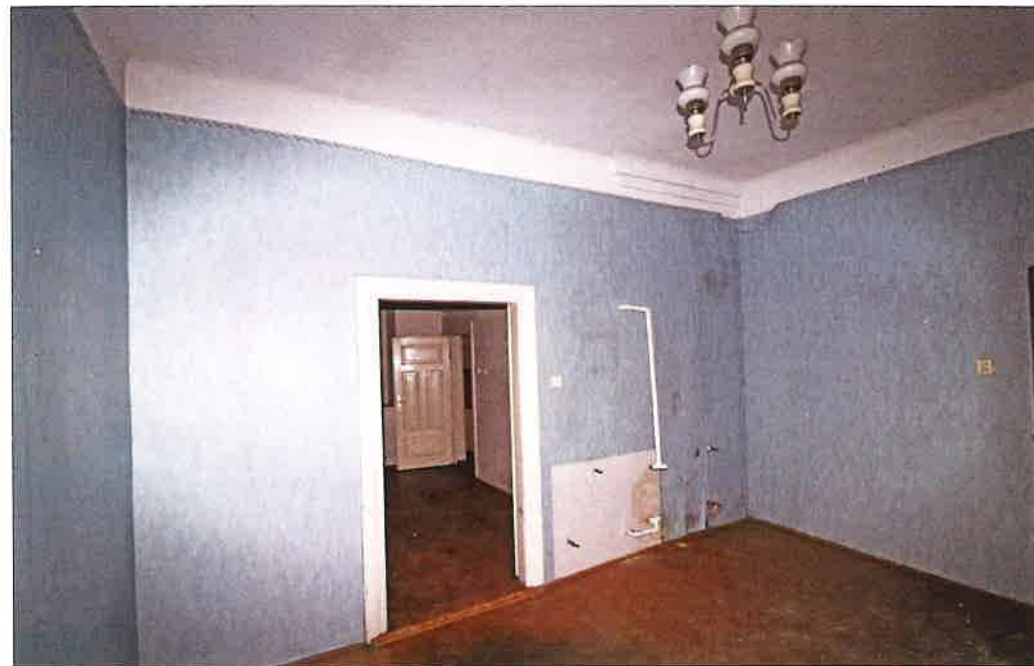
Pomieszczenie w zachodnim narożu budynku, widok w kierunku północno-wschodnim. (fot. Jakub Andrzejewski, 2020 r.)
