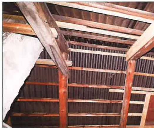
Szczytu dachu w środkowej poddasza z krokwiemi, łątami oraz pokrycia z falistych płyt bitumicznych. (fot. Jakub Andrzejewski, 2020 r. )
