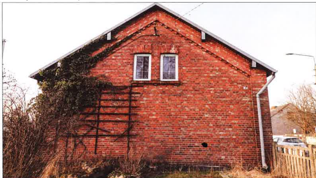
Elewacja południowo-wschodnia budynku. (fot. Jakub Andrzejewski, 2020 r.)
