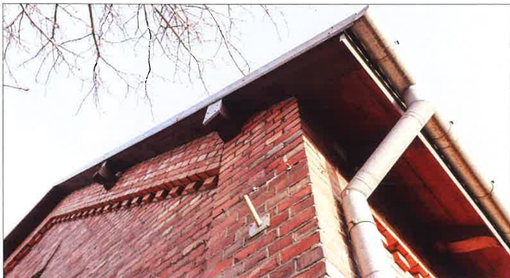
Okap połączeni dachowej przy narożu zachodnim, widoczne zdobnie zakończone płatwie oraz krokwie oraz wtórnie wykonana obróbka blacharska. (fot. Jakub Andrzejewski, 2020 r.)
