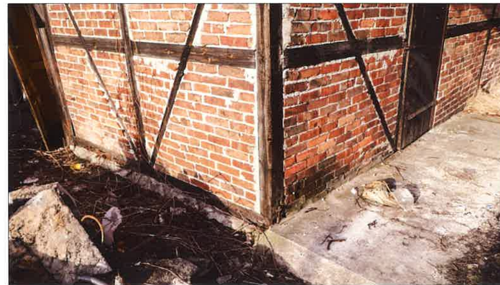
Przyziemie budynku gospodarczego, po prawej stronie widoczna podwalina zakryta warstwą betonu przy elewacji południowo-wschodniej. (fot. Jakub Andrzejewski, 2020 r.)
