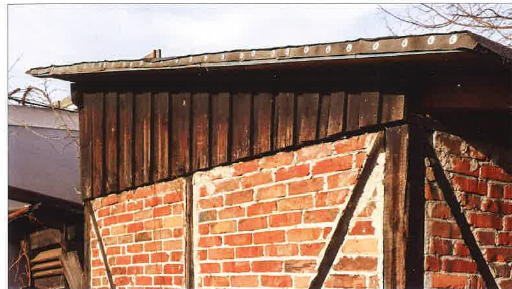
Deskowanie szczytu elewacji południowo-zachodniej. (fot. Jakub Andrzejewski, 2020 r.)
