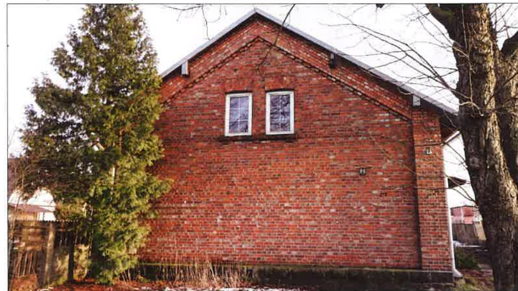
Elewacja północno-zachodnia budynku. (fot. Jakub Andrzejewski, 2020 r.)
