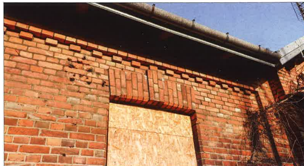
Elewacja południowo-zachodnia, widoczny prosty fryz ząbkowy powyżej otworu okiennego. (fot. Jakub Andrzejewski, 2020 r.)
