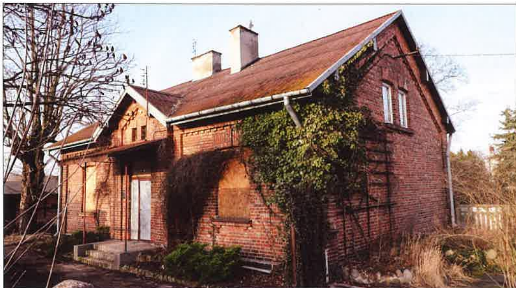
Widok ogólny budynku od strony południowej, od strony linii kolejowej. (fot. Jakub Andrzejewski, 2020 r.)
