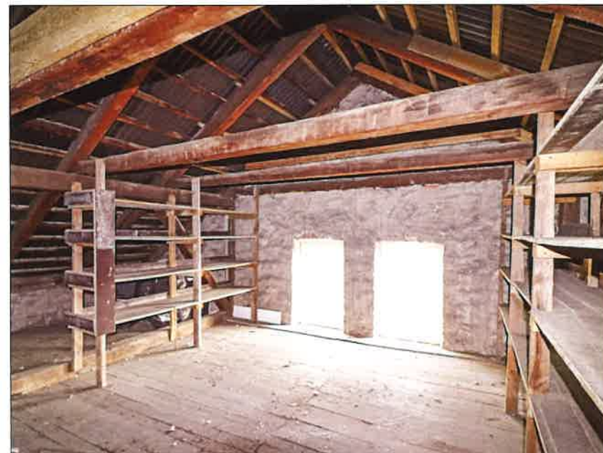
Ściana elewacji południowo-wschodniej w kondygnacji poddasza, widoczne dwa oryginalne otwory okienne, drewnianą konstrukcję krokwiowo-jętkową oraz podłogę pokrytą deskami. Wtórnie wykonane zostało poszycie połaci dachowych z falistych płyt bitumicznych. (fot. Jakub Andrzejewski, 2020 r. )
