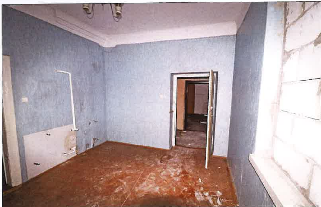
Pomieszczenie w zachodnim narożu budynku, widok w kierunku wschodnim, w stronę korytarza głównego oraz pomieszczeń drugiego mieszkania. (fot. Jakub Andrzejewski, 2020 r.)
