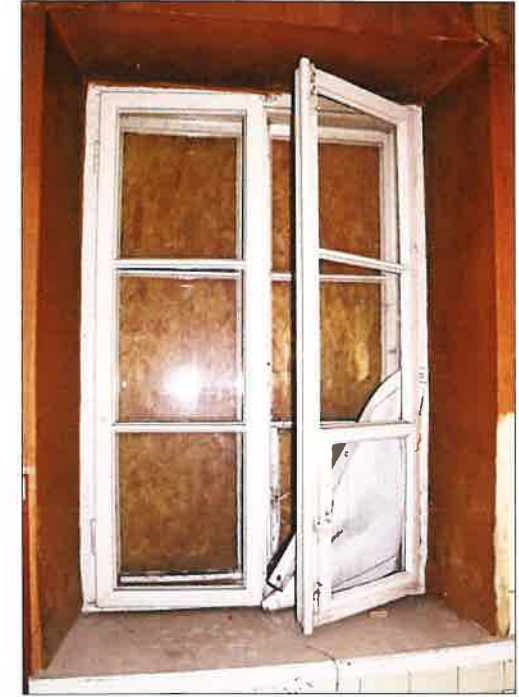
Oryginalne drewniane okno ościeżnicowe typu polskiego w pomieszczeniu dawnej kuchni. (fot. Jakub Andrzejewski, 2020 r.)
