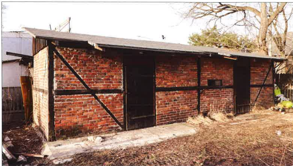
Widok budynku gospodarczego od strony południowej. (fot. Jakub Andrzejewski, 2020 r.)
