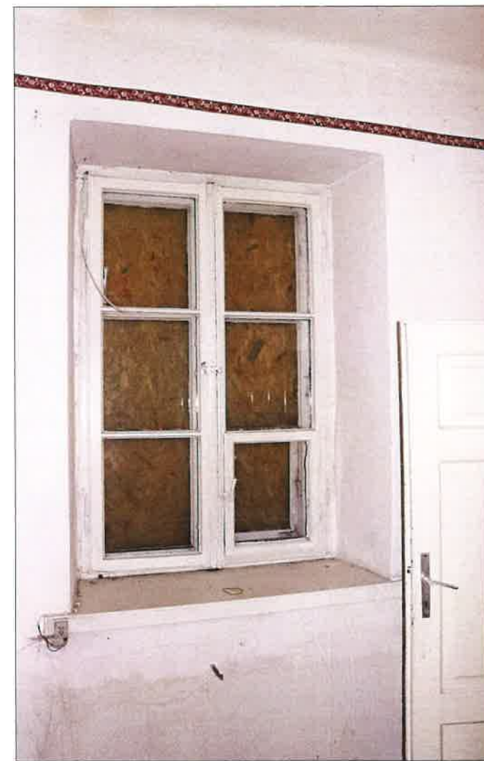
Oryginalne drewniane okno ościeżnicowe typu polskiego w ścianie elewacji północno-wschodniej. (fot. Jakub Andrzejewski, 2020 r.)
