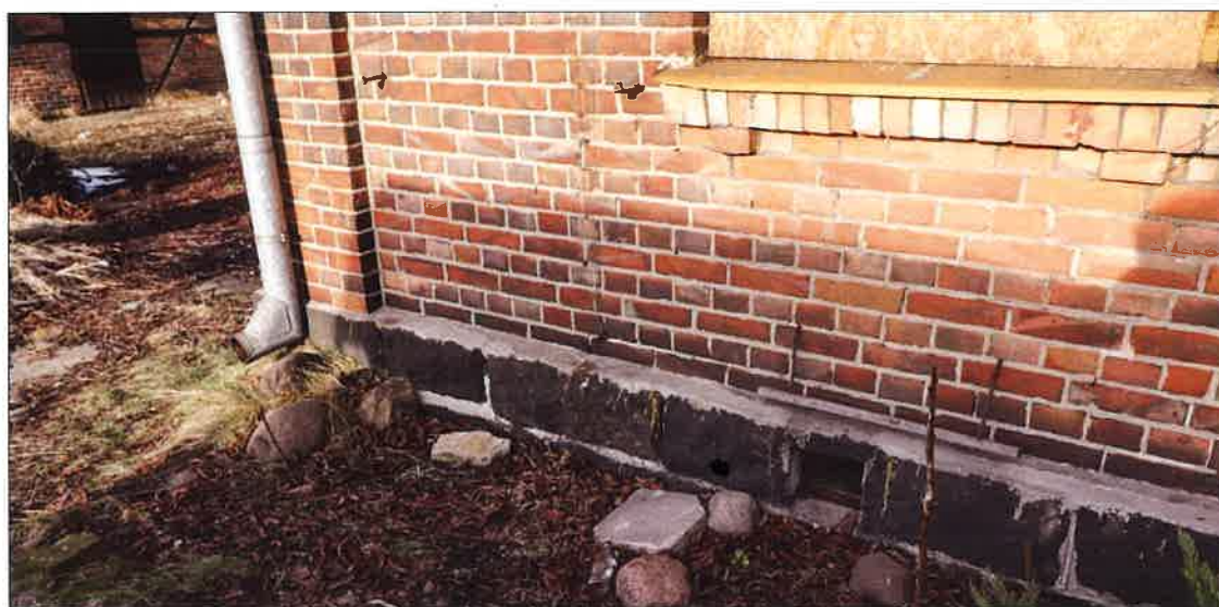
Ściana fundamentowa w elewacji południowo-zachodniej wykonana z granitowych ciosów kamiennych na zaprawie wapiennej. (fot. Jakub Andrzejewski, 2020 r.)
