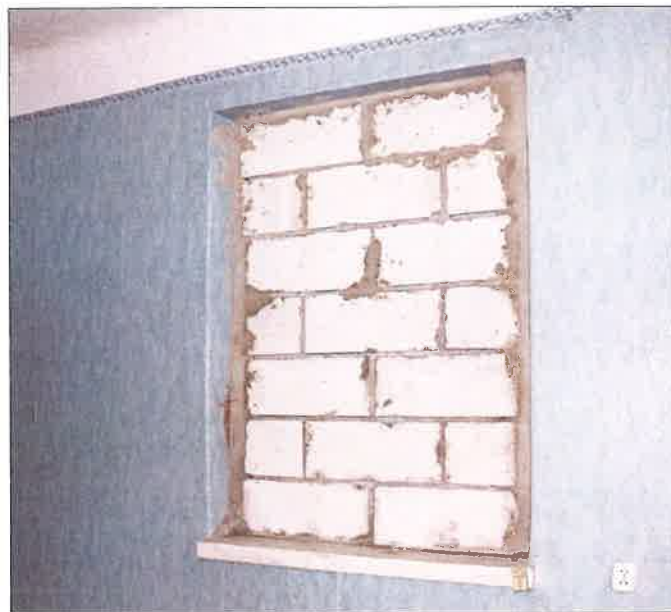
Pomieszczenie w zachodnim narożu budynku, widoczny wtórnie zamurowany otwór okienny w ścianie elewacji południowo-zachodniej. (fot. Jakub Andrzejewski, 2020 r.)
