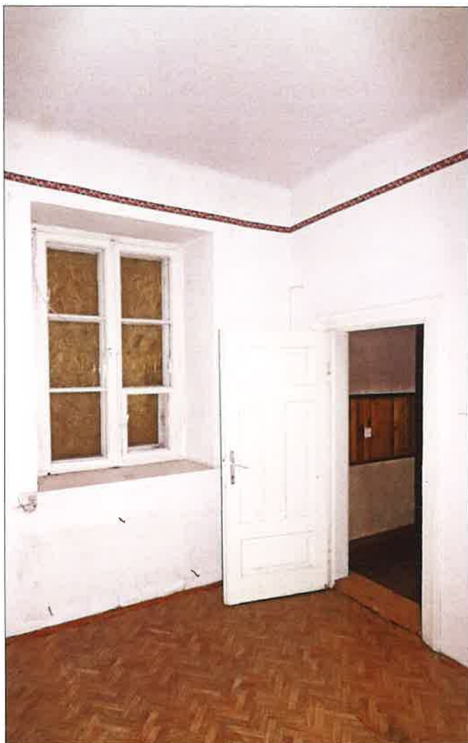
Pomieszczenie w północnym narożu budynku, widoczna stolarka okienna i drzwiowa, okno zostało wtórnie zakryte od strony zewnętrznej. (fot. Jakub Andrzejewski, 2020 r.)
