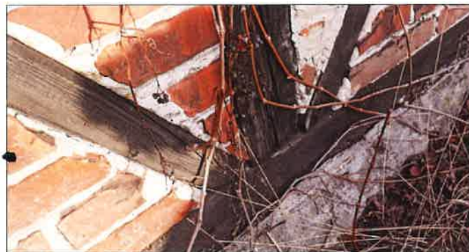
Detal połączenia konstrukcji w przyziemiu: podwaliny, słupa środkowego i zastrzałów. (fot. Jakub Andrzejewski, 2020 r.)
