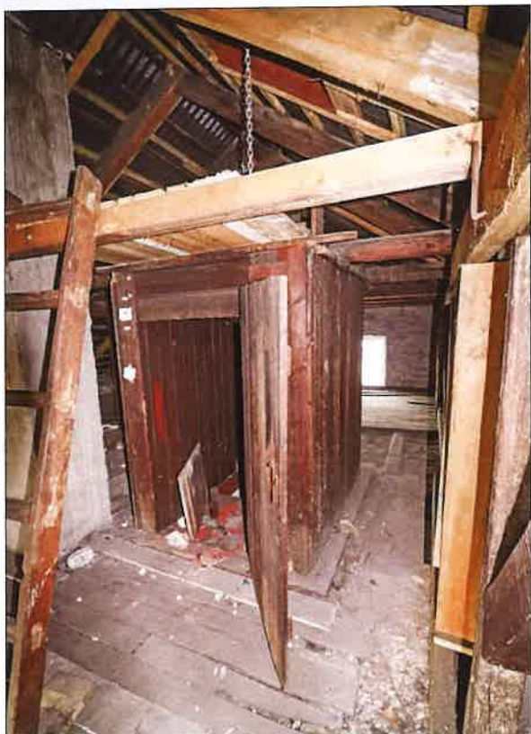
Wyjście prowadzące do korytarza głównego w parterze budynku przypuszczalnie z oryginalnym deskowaniem. (fot. Jakub Andrzejewski, 2020 r. )
