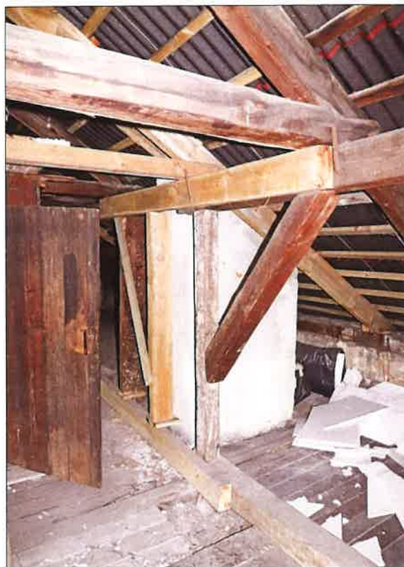
Ściana stolcowa złożona z częściowo wymienionych elementów konstrukcyjnych tj. płatwi, stolca (słupa) oraz podwaliny. (fot. Jakub Andrzejewski, 2020 r. )
